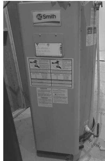
Réservoir à eau chaude (600 volts)
